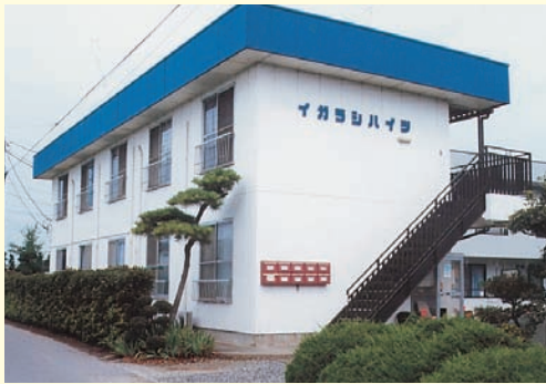
鉄骨ALC2階建
