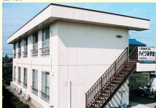
鉄骨ALC2階建
