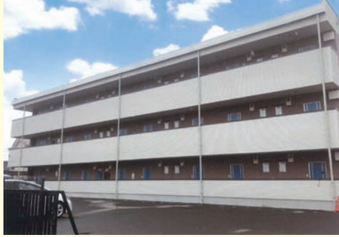
鉄筋ALC3階建
