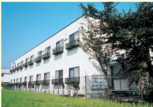
鉄骨ALC2階建
