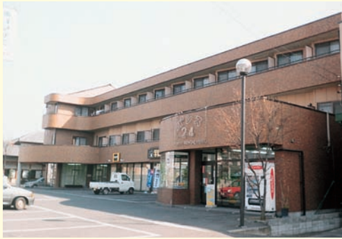
鉄骨ALC3階建
