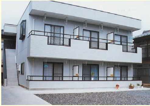
鉄骨ALC2階建
