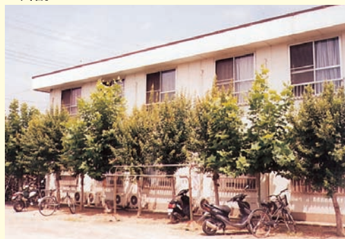
鉄骨ALC2階建
