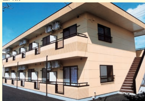
鉄骨ALC2階建
