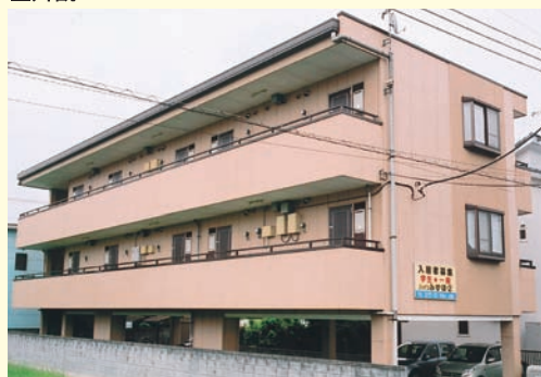
鉄骨ALC3階建
