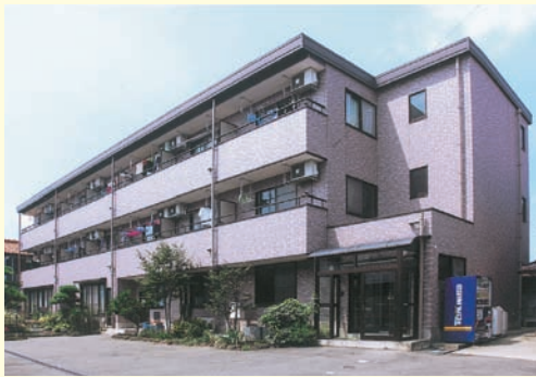
鉄骨ALC3階建
