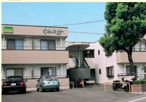
鉄骨ALC2階建
