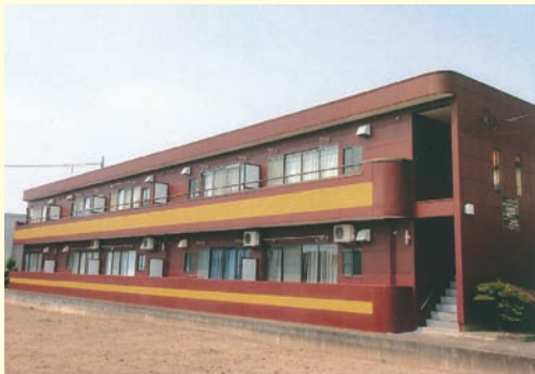
鉄骨ALC2階建
