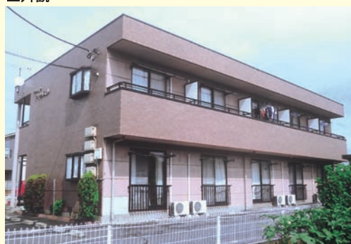
鉄骨ALC2階建
