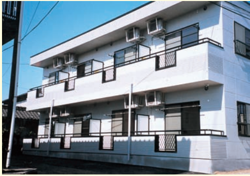
鉄骨ALC2階建
