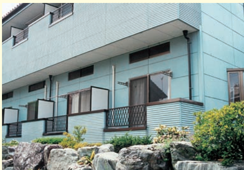
鉄骨ALC2階建
